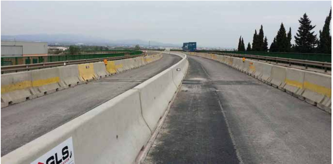
N-340 Puente sobre el río Ebro (Amposta)
