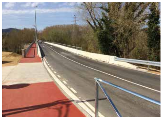
BV-5121 Puente sobre río Tordera
