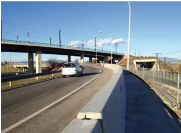
C-33 Línea Alta Velocidad (Moncada)
