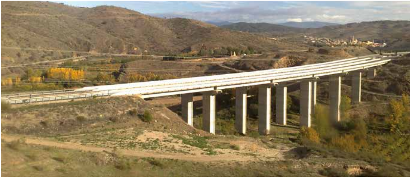
A-2 Viaducto en Arcos de Jalón
